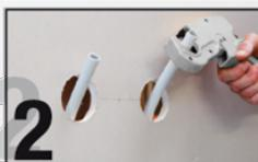
Positionner les coudes sur les tubes et réaliser le sertissage.
