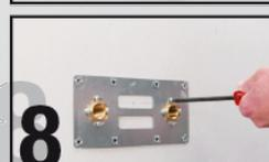
La platine, par son épaisseur réduite, sera facilement noyée dans le ciment colle utilisé pour la pose de la faïence.
