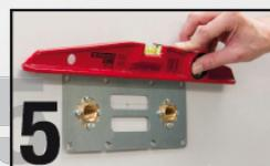
Percer les huit trous de fixation dans la cloison en veillant à ne pas percer les tubes.
