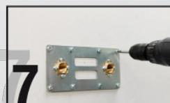
Serrer de façon définitive les vis de fixation des coudes sur la platine.
