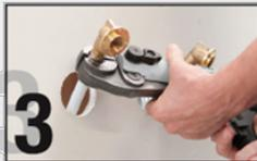
Fixer les coudes d'encastrement sur la platine sans les serrer (vis fournies). Ne jamais plier les canalisations FLUXO®.
