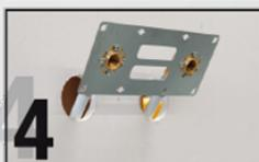
Présenter la platine horizontalement, à l'aide d'un niveau.
