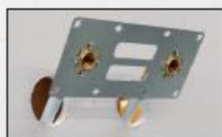
**4** Fixer les coudes d'encastrement sur la platine sans les serrer. Ne jamais plier les canalisations FLUXO®.
