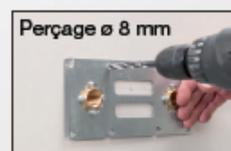
**6** Percer les huit trous de fixation dans la cloison en veillant à ne pas percer les tubes.
