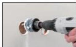
**1** Percer deux trous de 67 mm de diamètre dans la cloison de plâtre à l'aide d'une scie cloche (cf. gabarit).
